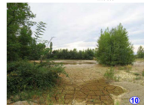
10 Bassins de décantation
